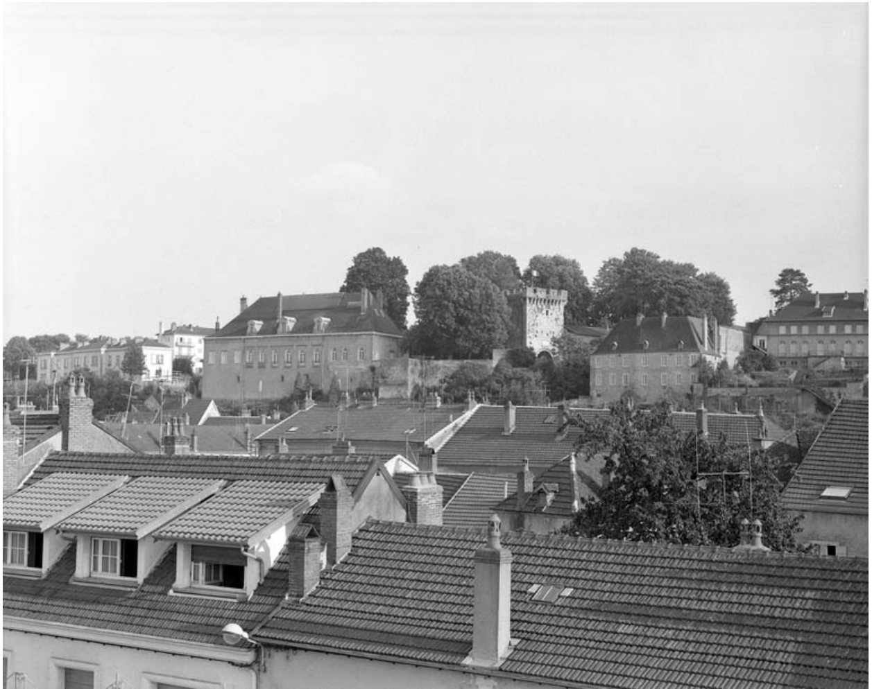
Vue éloignée depuis la ville basse.
