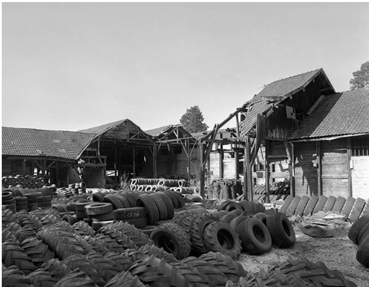
Magasins industriels depuis le nord.
