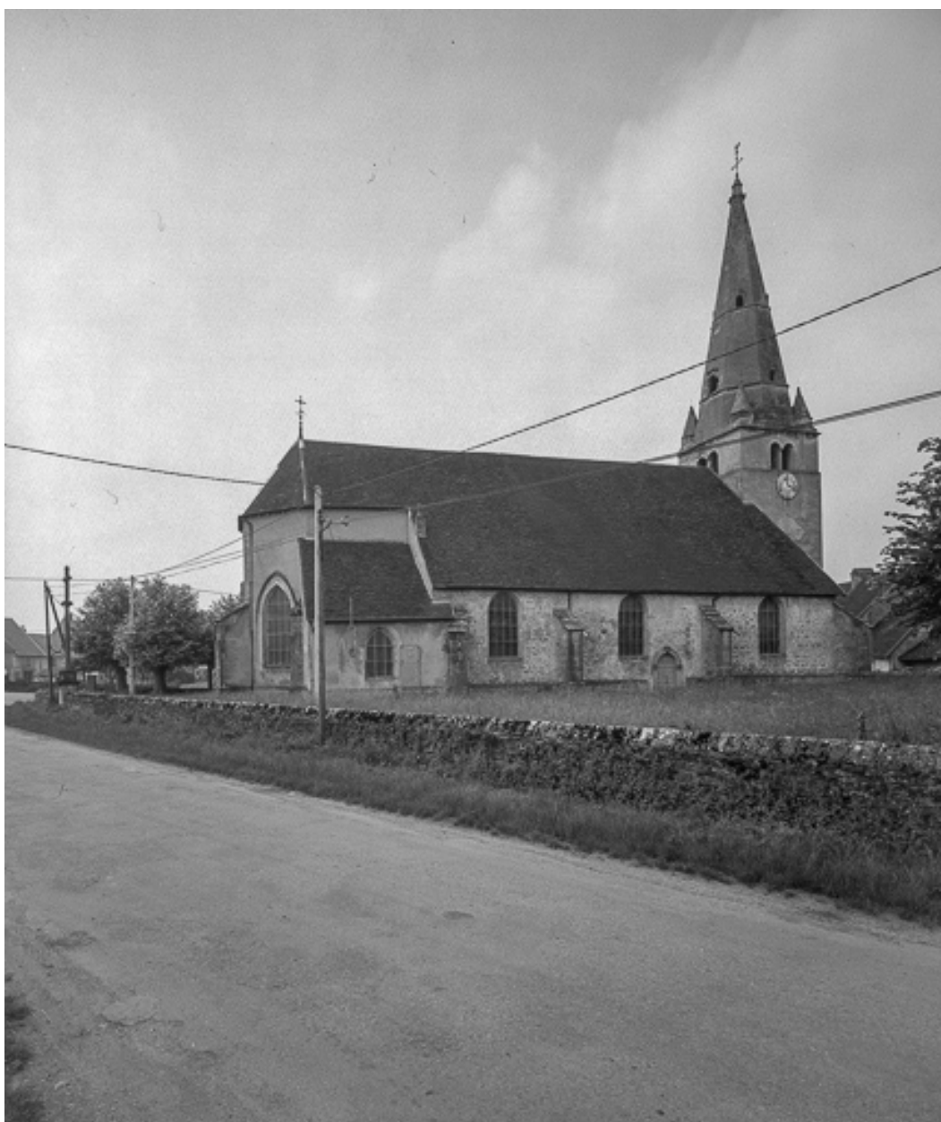
Façade latérale nord.
