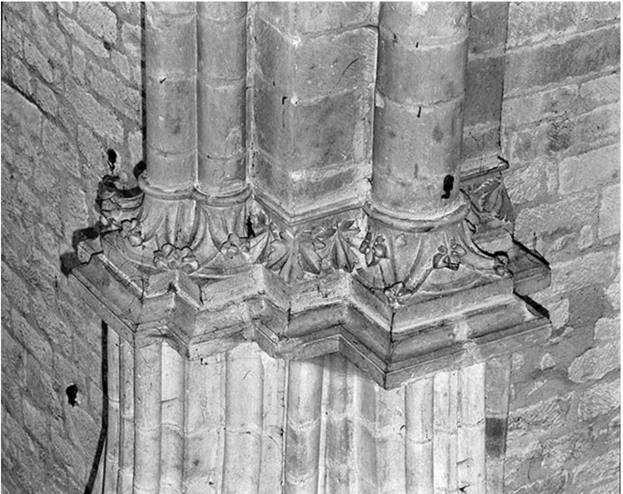
Croisée du transept : pilier postérieur gauche, détail des chapiteaux.
