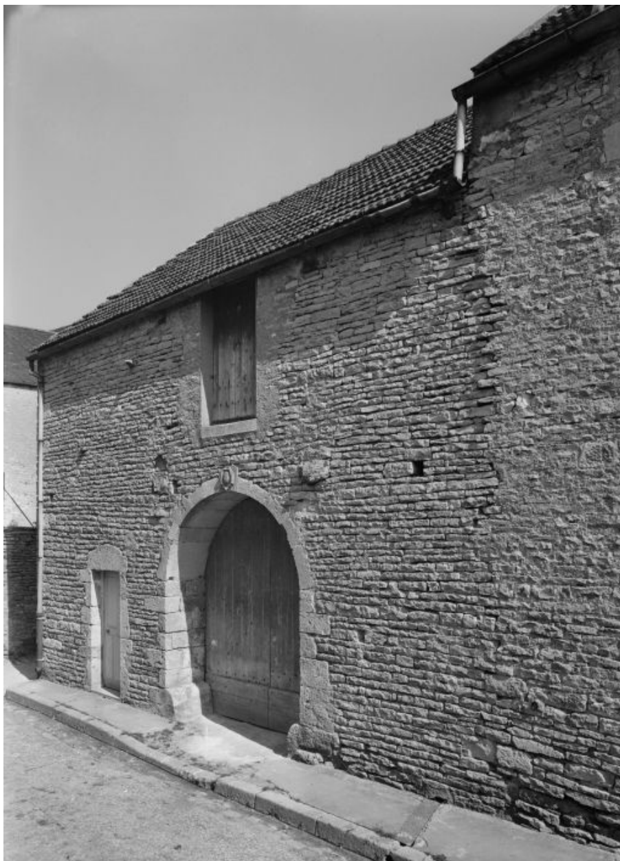
Façade de la grange.
