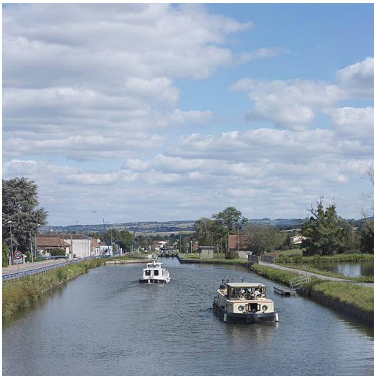
Echelle d'écluses depuis le pont sur l'écluse 01.
