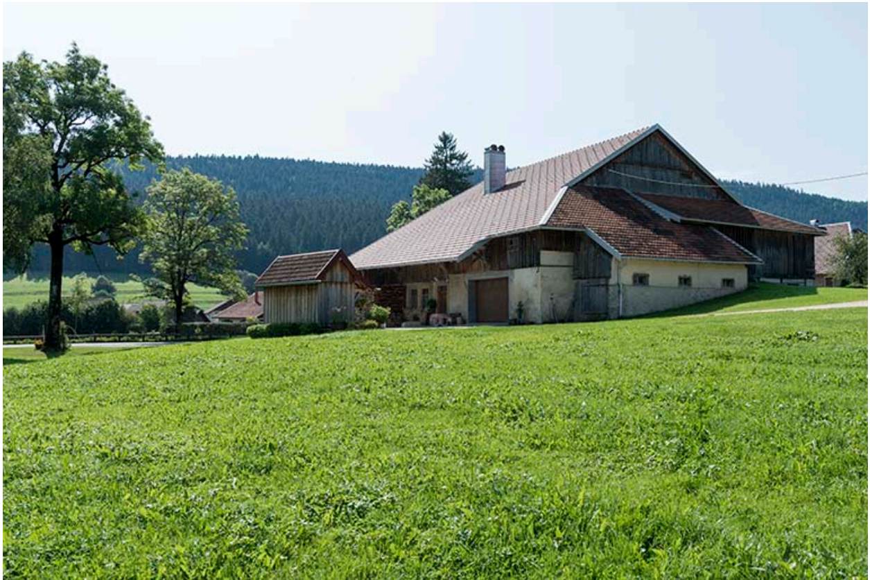
Ferme : façades postérieure et latérale droite.
