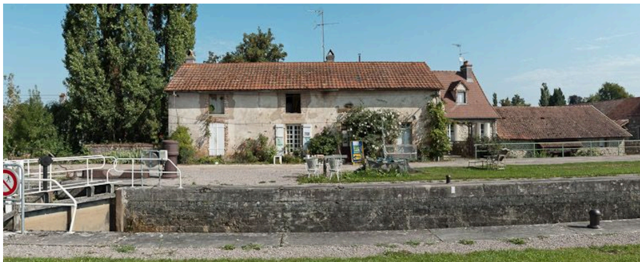
Vue de face de la maison éclusière.
