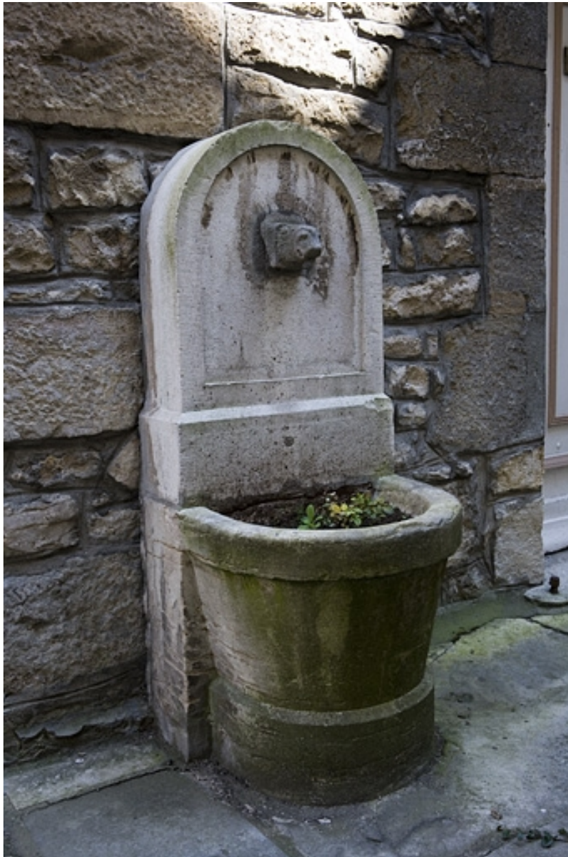
Détail de la borne fontaine à gauche de la cour.
