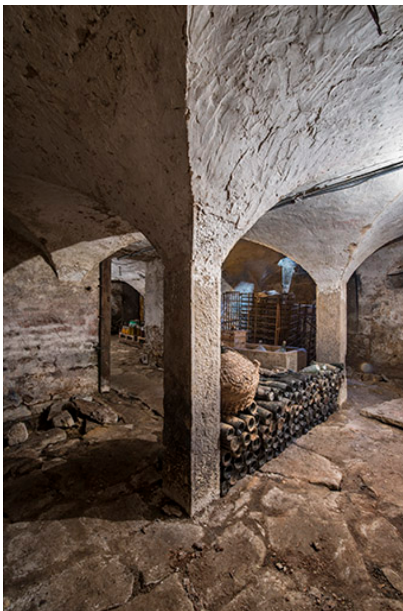
Détail d'une colonne supportant les voûtes.
