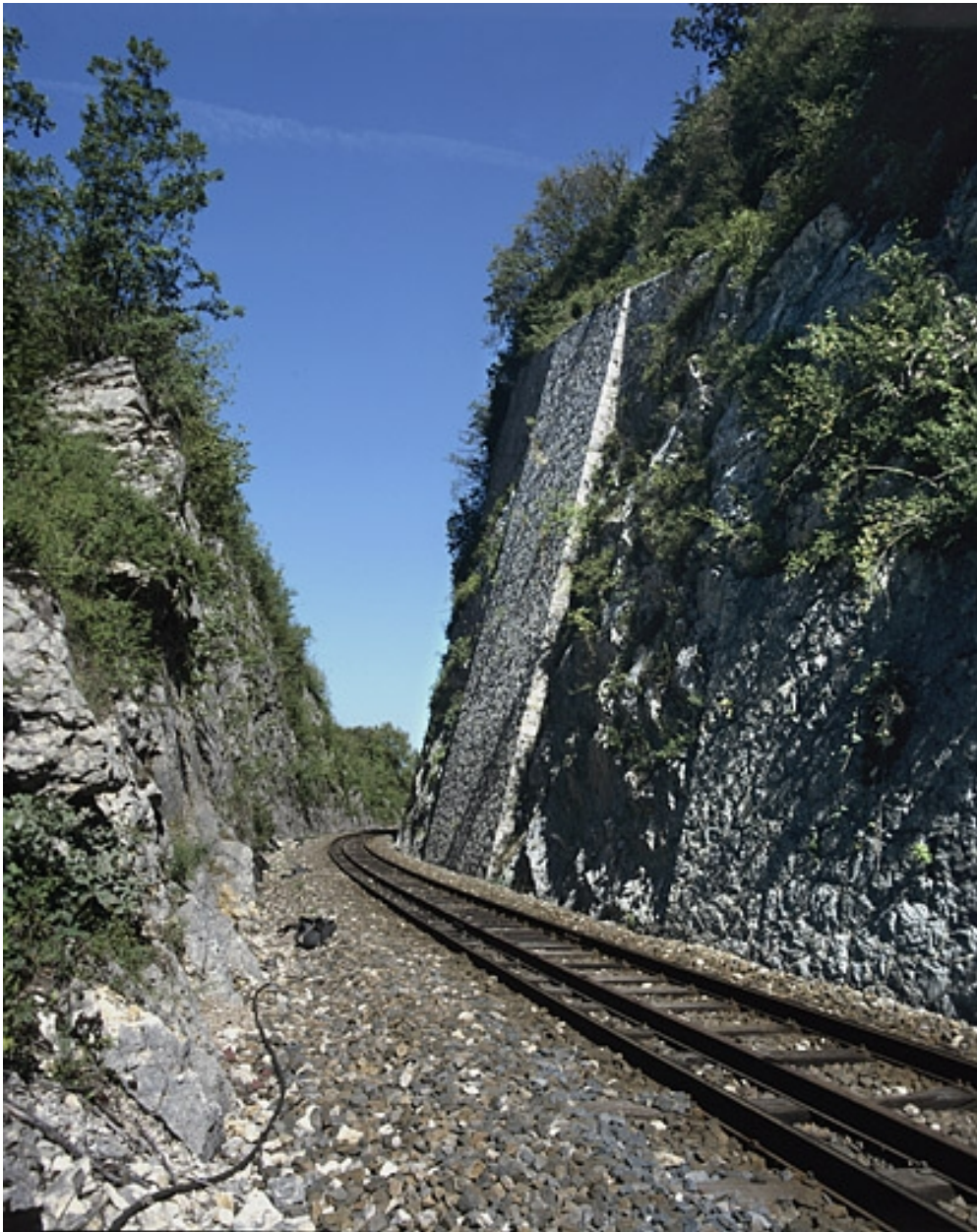
Vue d'ensemble, depuis le côté La Cluse (sud-ouest).
