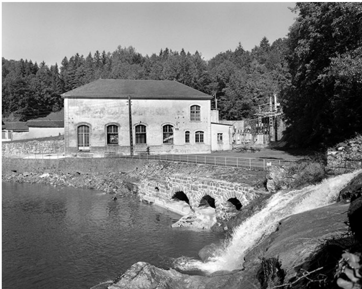
Façade postérieure de la centrale.
