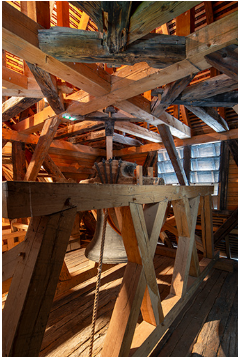
Campanile de la sacristie. Charpente du beffroi.
