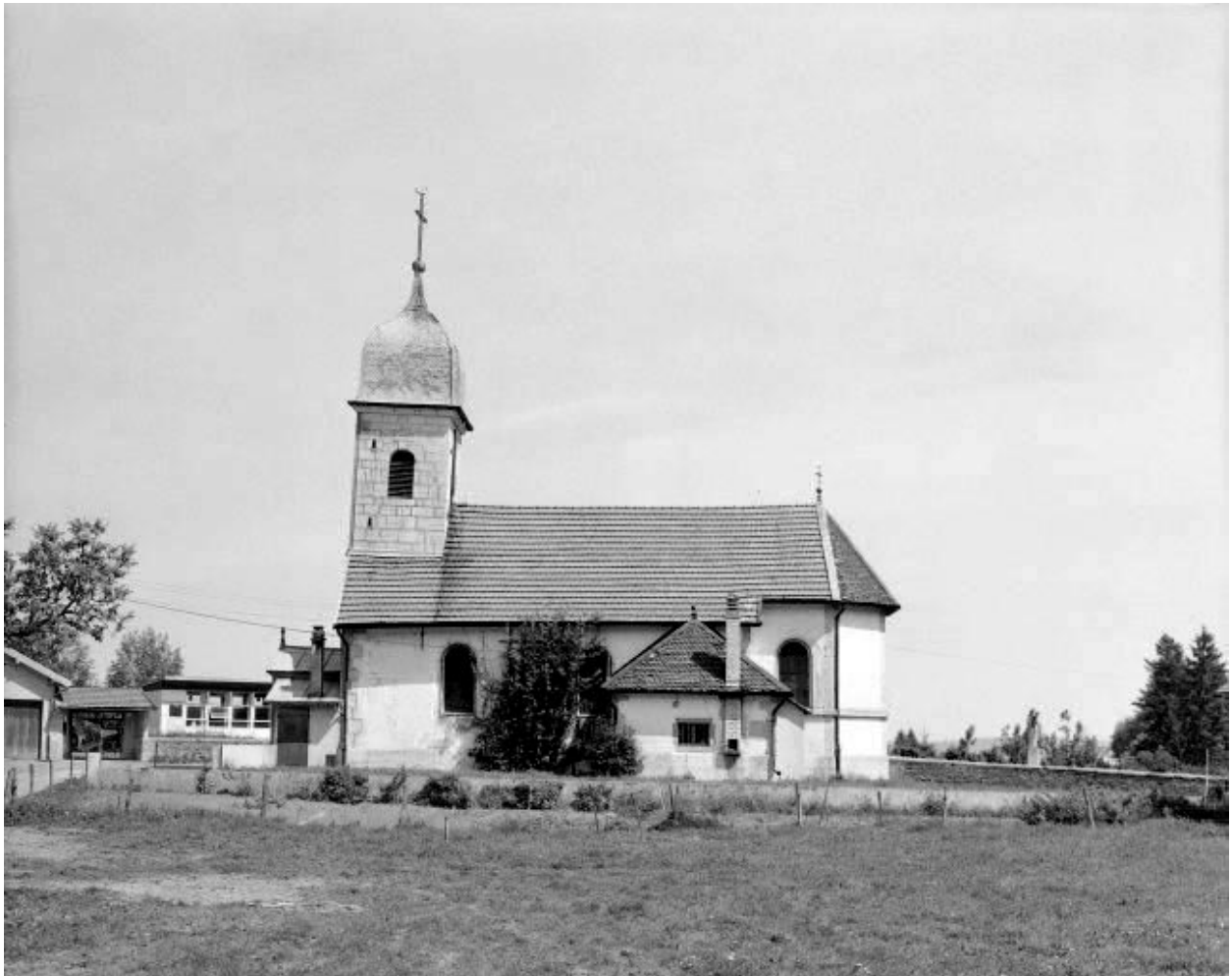
Façade latérale droite.
