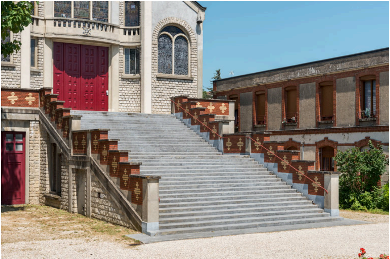
Escalier menant au parvis. Vue de trois quarts. A droite, la chapelle.
