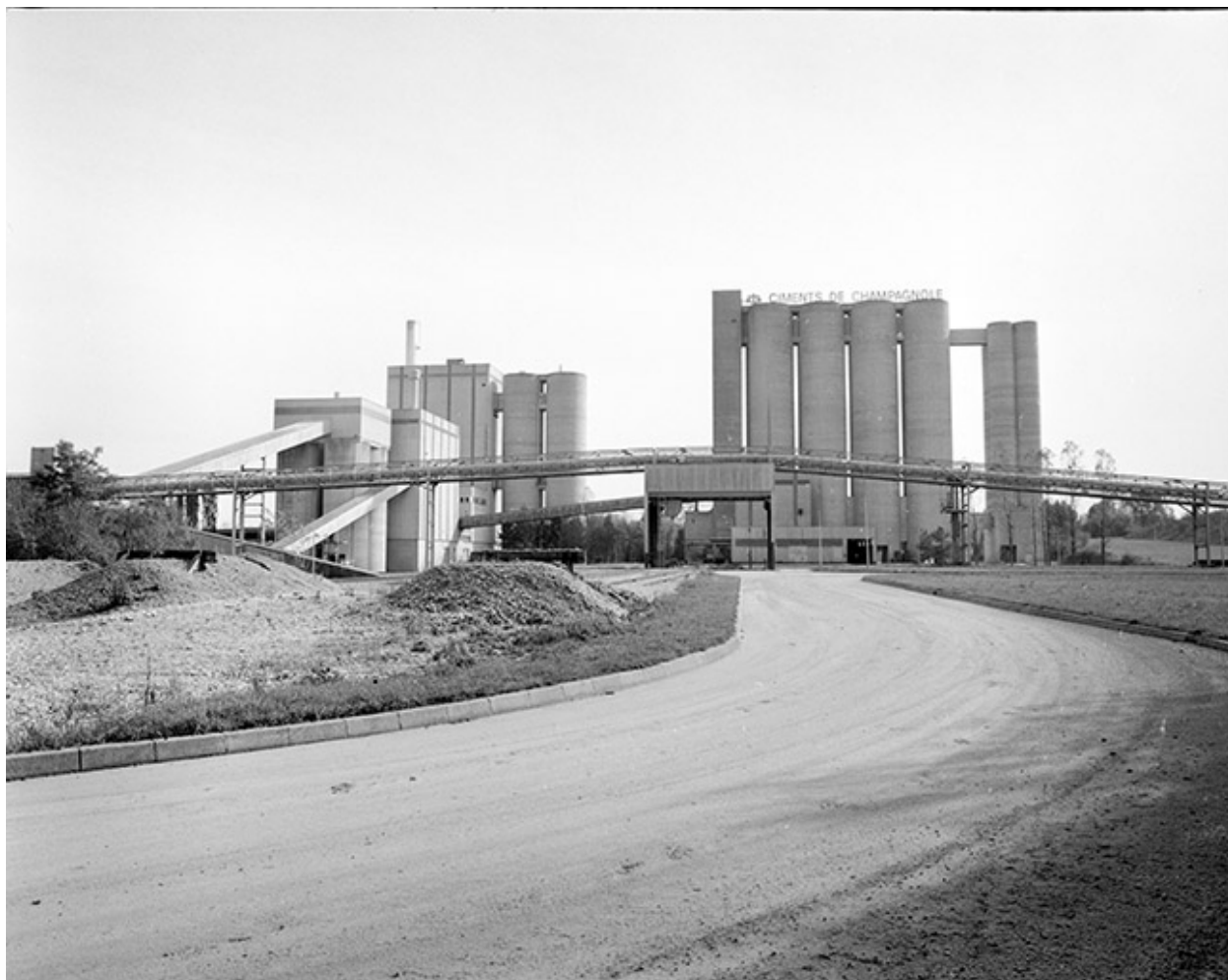
Vue d'ensemble depuis le nord-ouest : transporteur à bande, atelier de fabrication à gauche, silos et conditionnement à droite.
