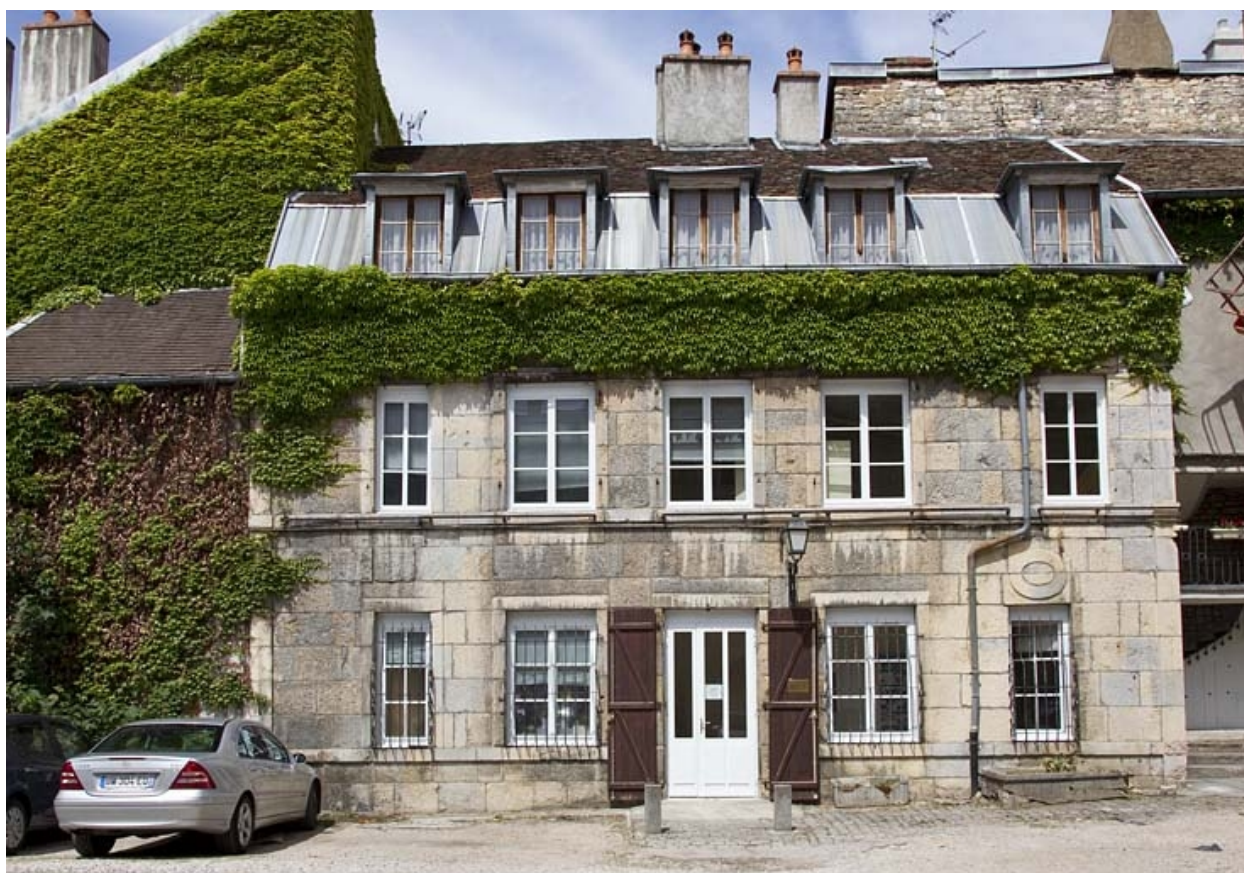
Troisième logis secondaire, façade antérieure : de face.
