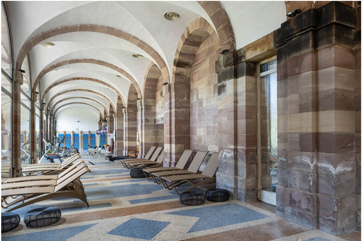
Galerie de l'aile du Bain gradué, vue en direction du sud.
