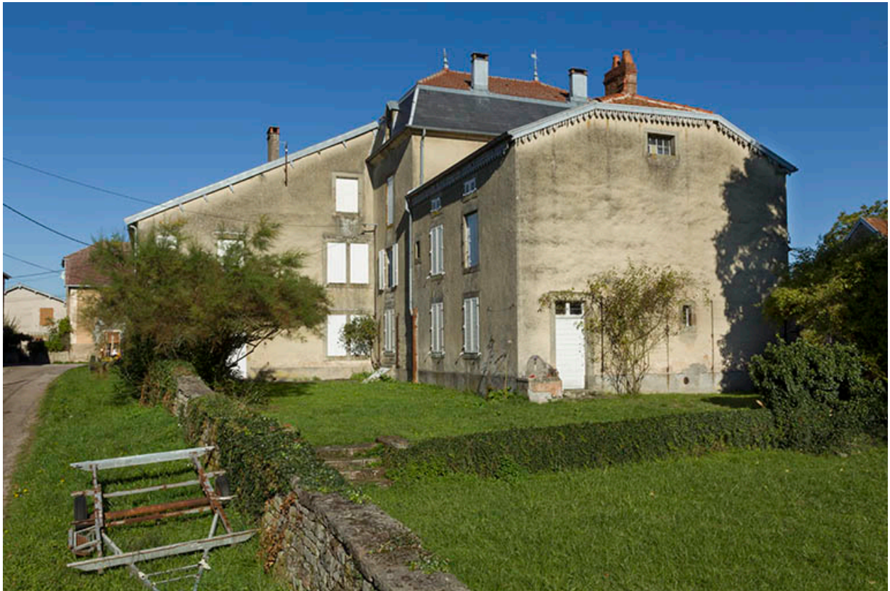
Maison, rue du Château, façades postérieures.
