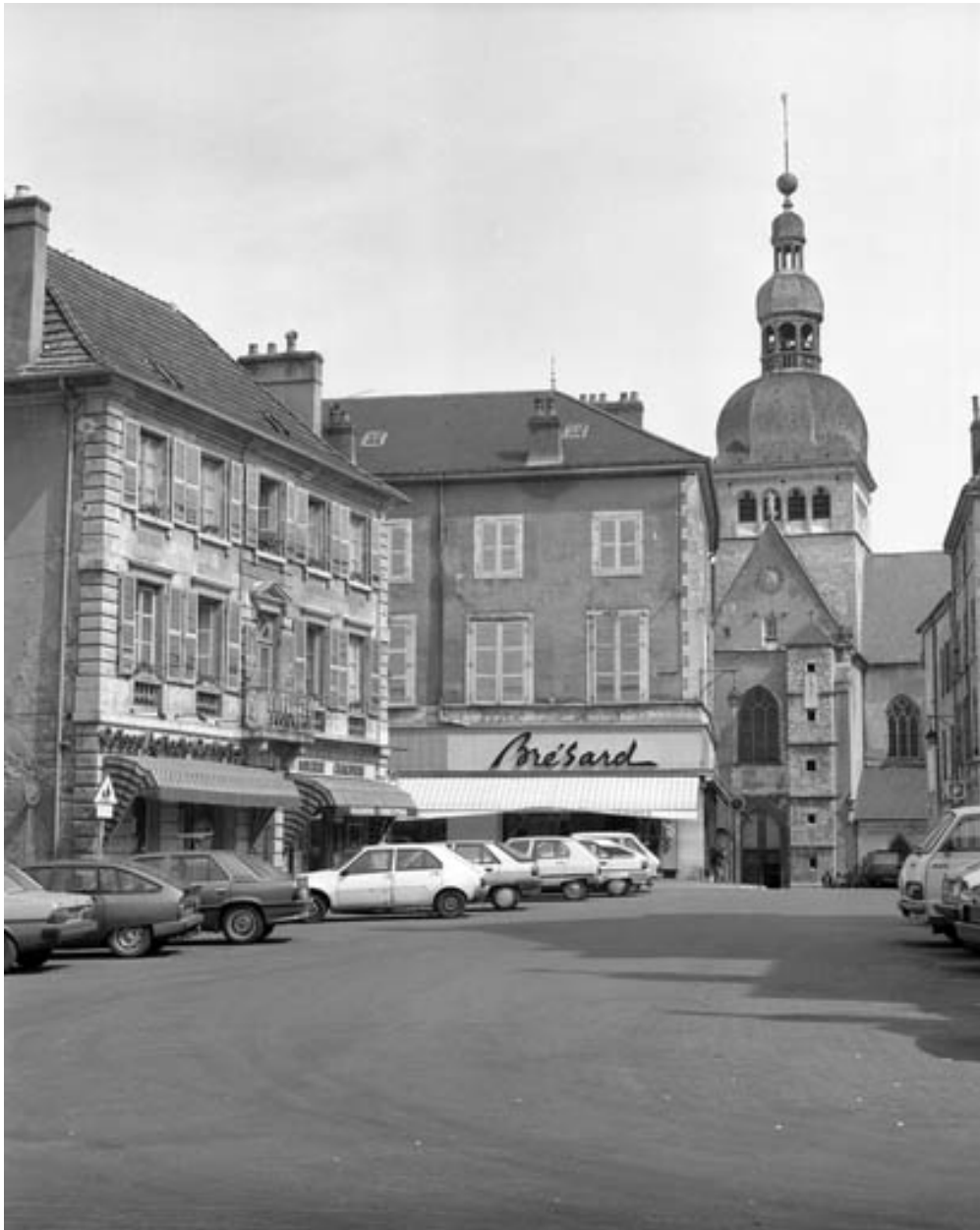
Clocher et bras droit du transept depuis la place Charles de Gaulle.
