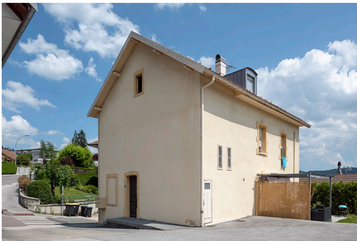
Façades postérieure et latérale droite.
