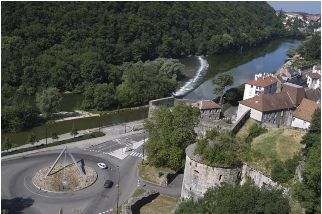
Vue d'ensemble plongeante sur le barrage.
