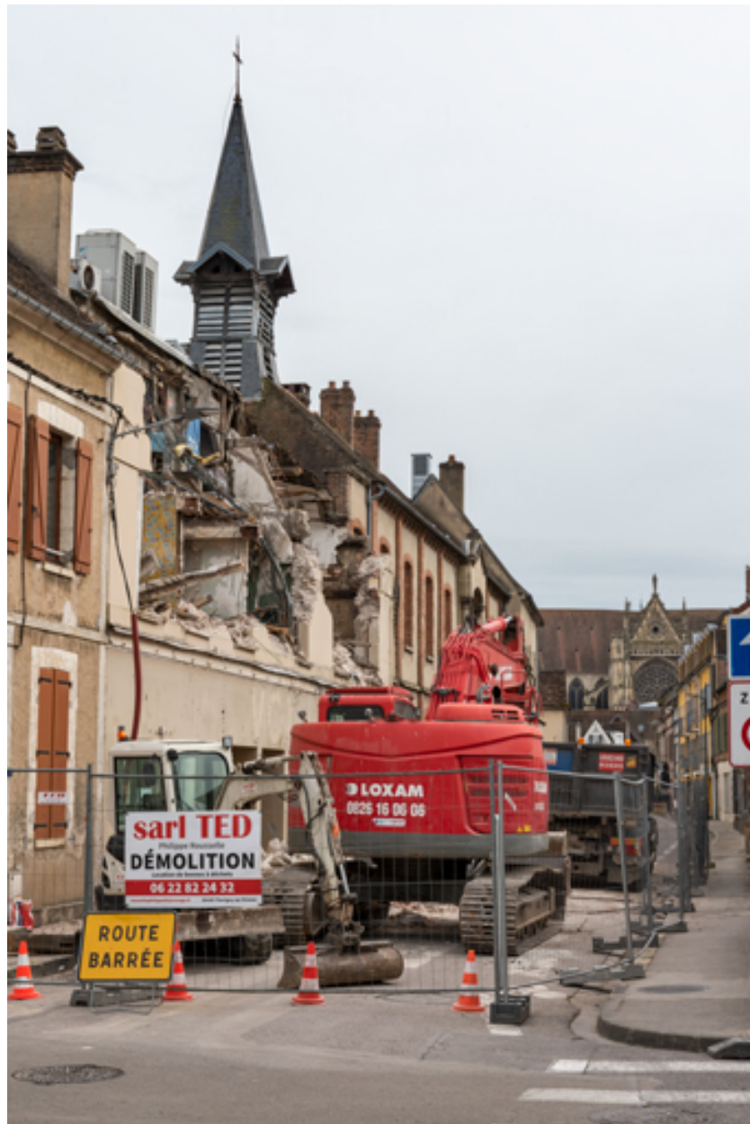
Cinéma Vox (14 rue Victor Guichard) en cours de démolition (22 mars 2023).
