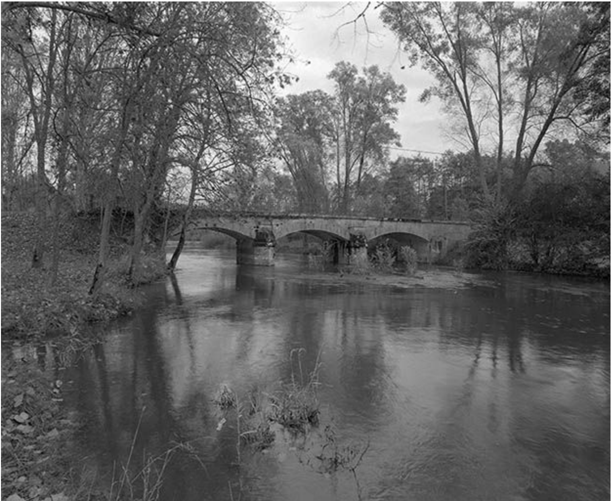
Vue prise depuis l'amont
