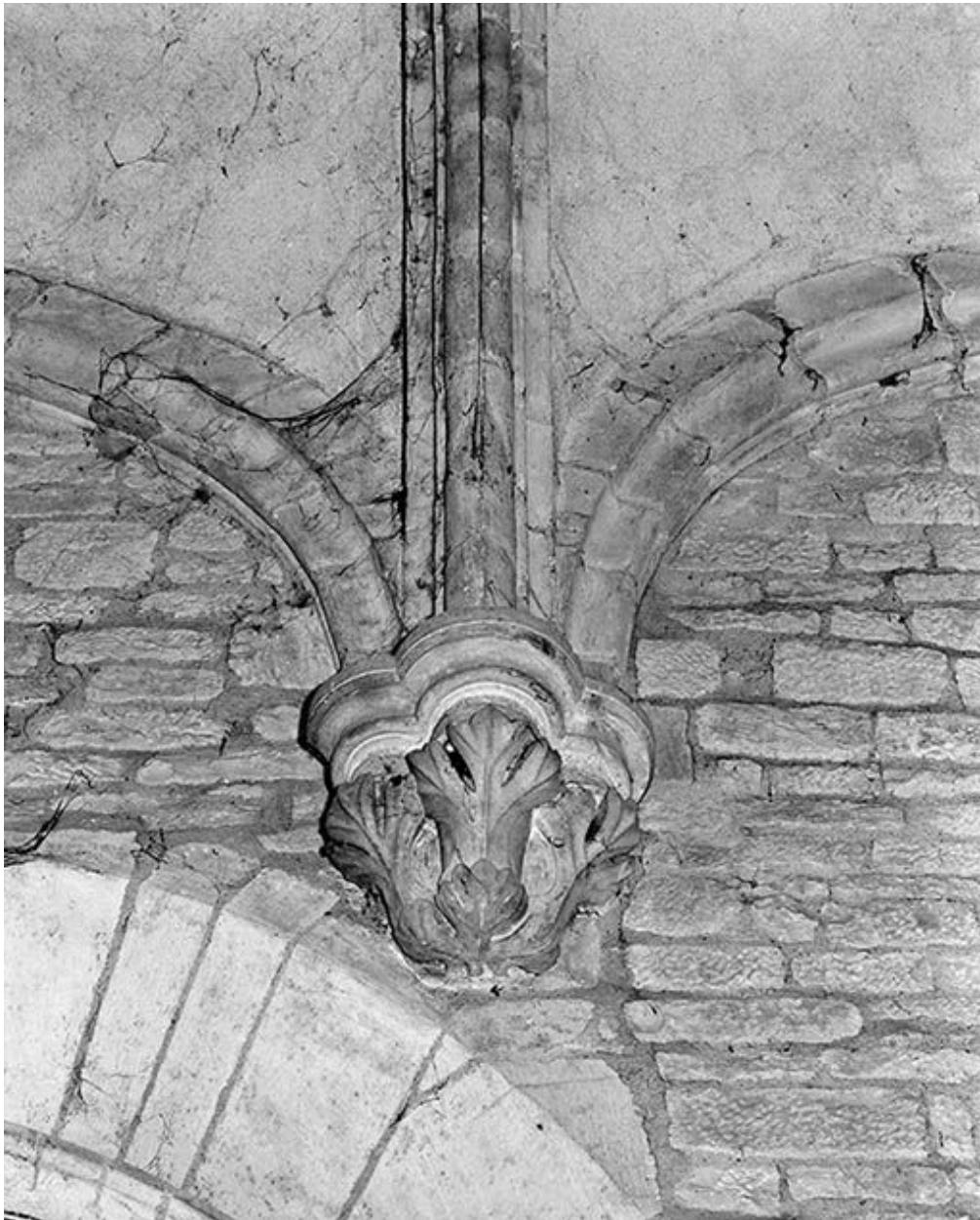
Choeur, voûte : culot droit.
