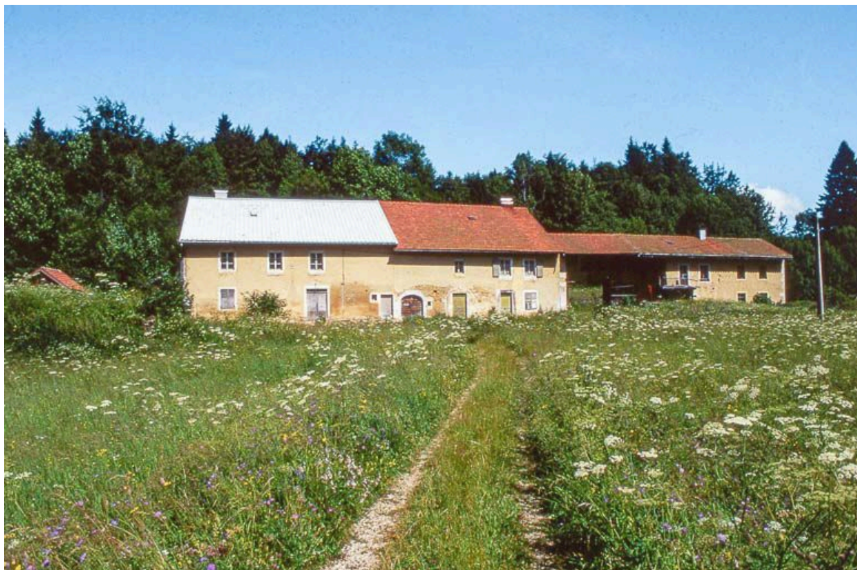
Ensemble de fermes mitoyennes situées au lieudit Les Repentys.
