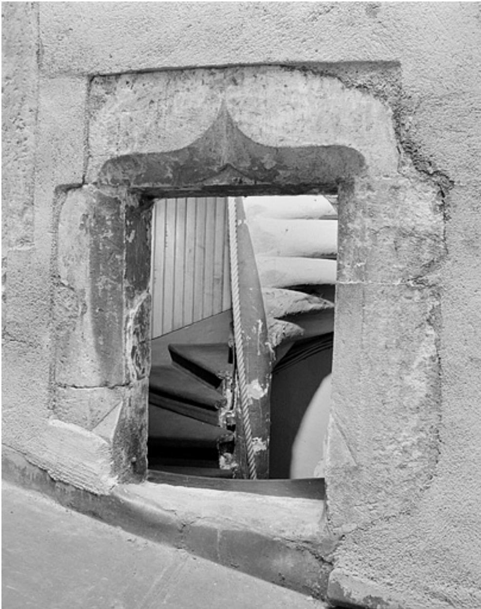
Maison 27, rue des Febvres. Escalier. Première moitié 16e siècle.
