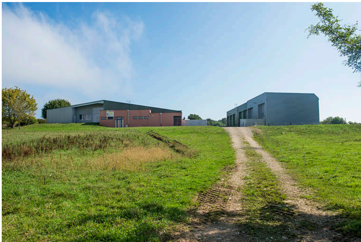
Vue d'ensemble, depuis les serres, à l'ouest.
