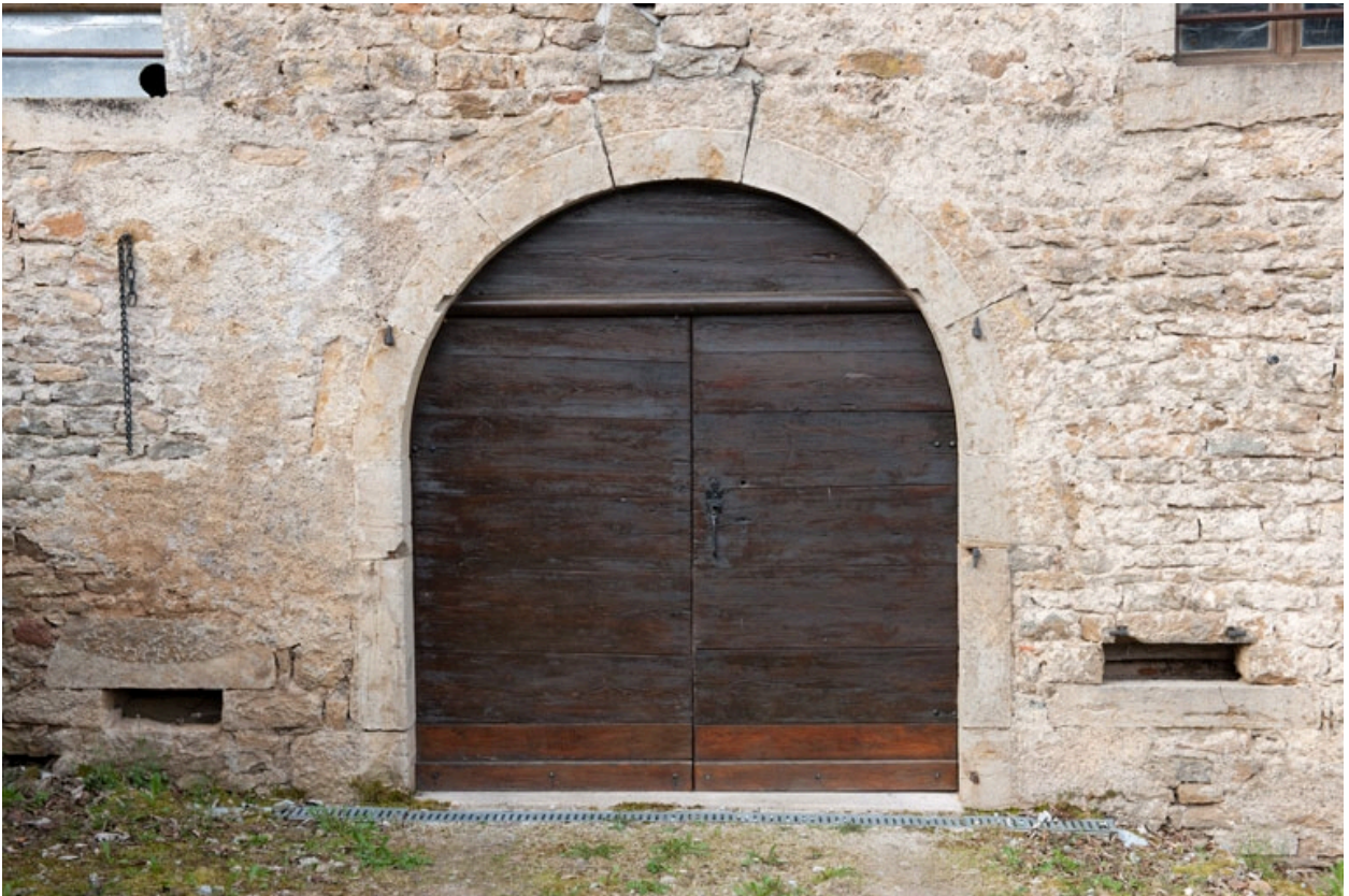
Grange : porte sur la façade latérale gauche.
