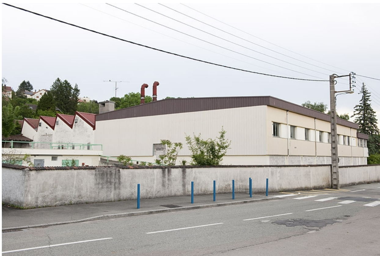
Vue d'ensemble depuis la rue.
