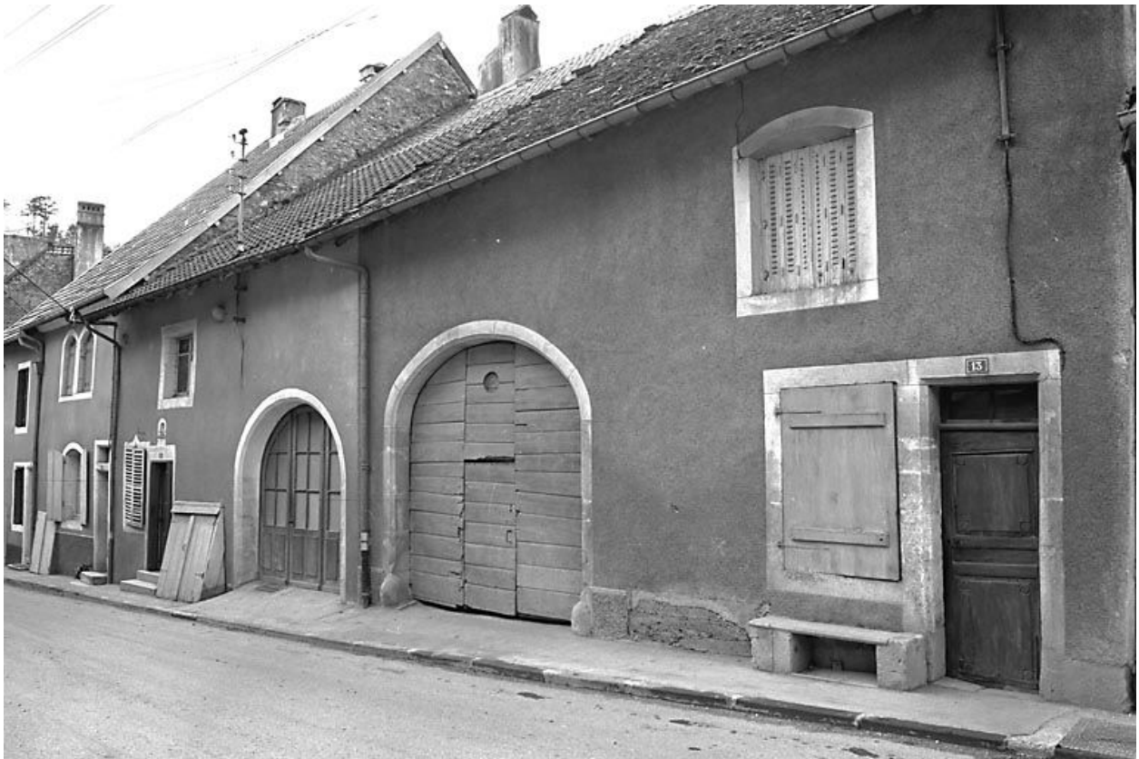
Maison de vigneron située 13 rue du Moulin.
