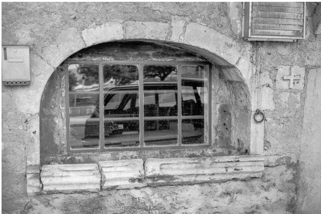
Fenêtre de l'écurie avec mangeoire.
