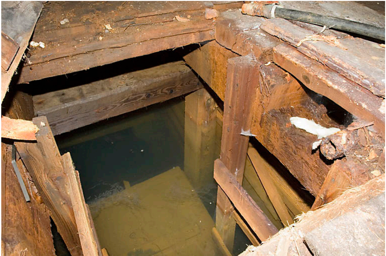
Grenier à sel. Vue oblique de la cuve des Allemands (2006).
