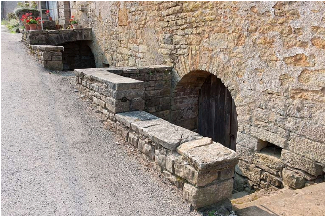
Accès aux caves.
