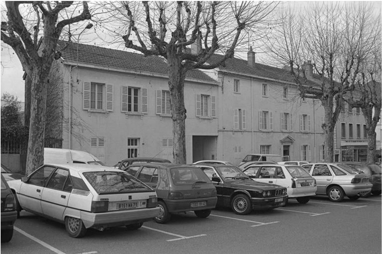
Façade antérieure du presbytère, vue de l'est.
