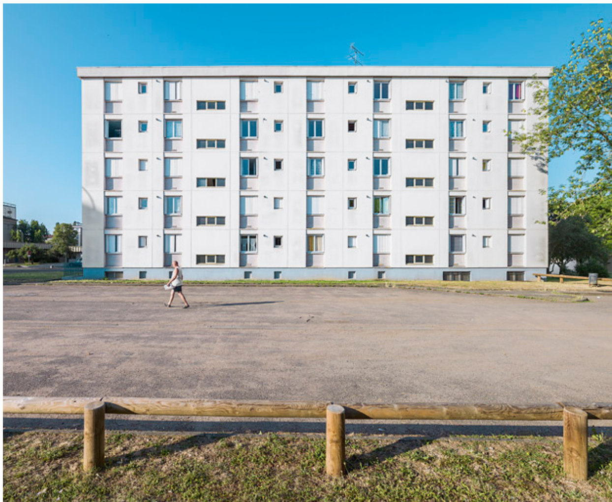
Bâtiment B-1, façade postérieure nord.
