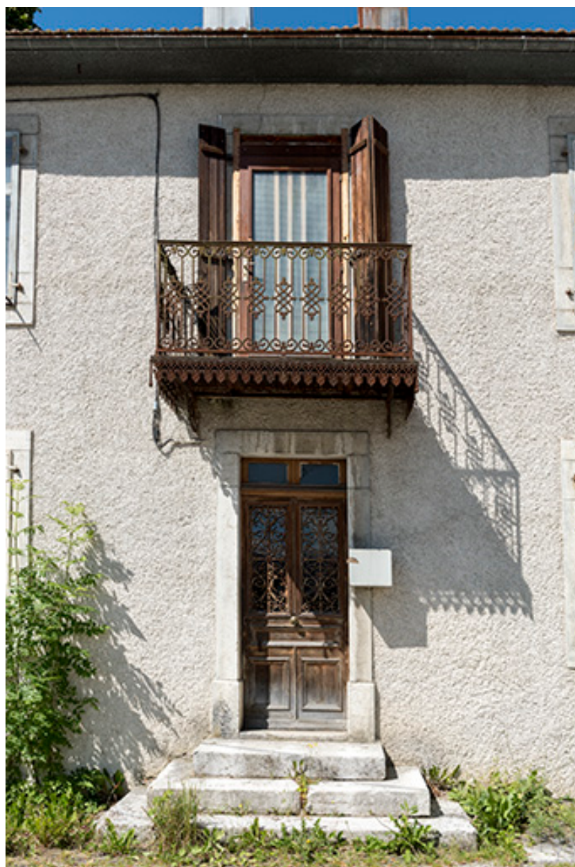
Façade antérieure : travée centrale.
