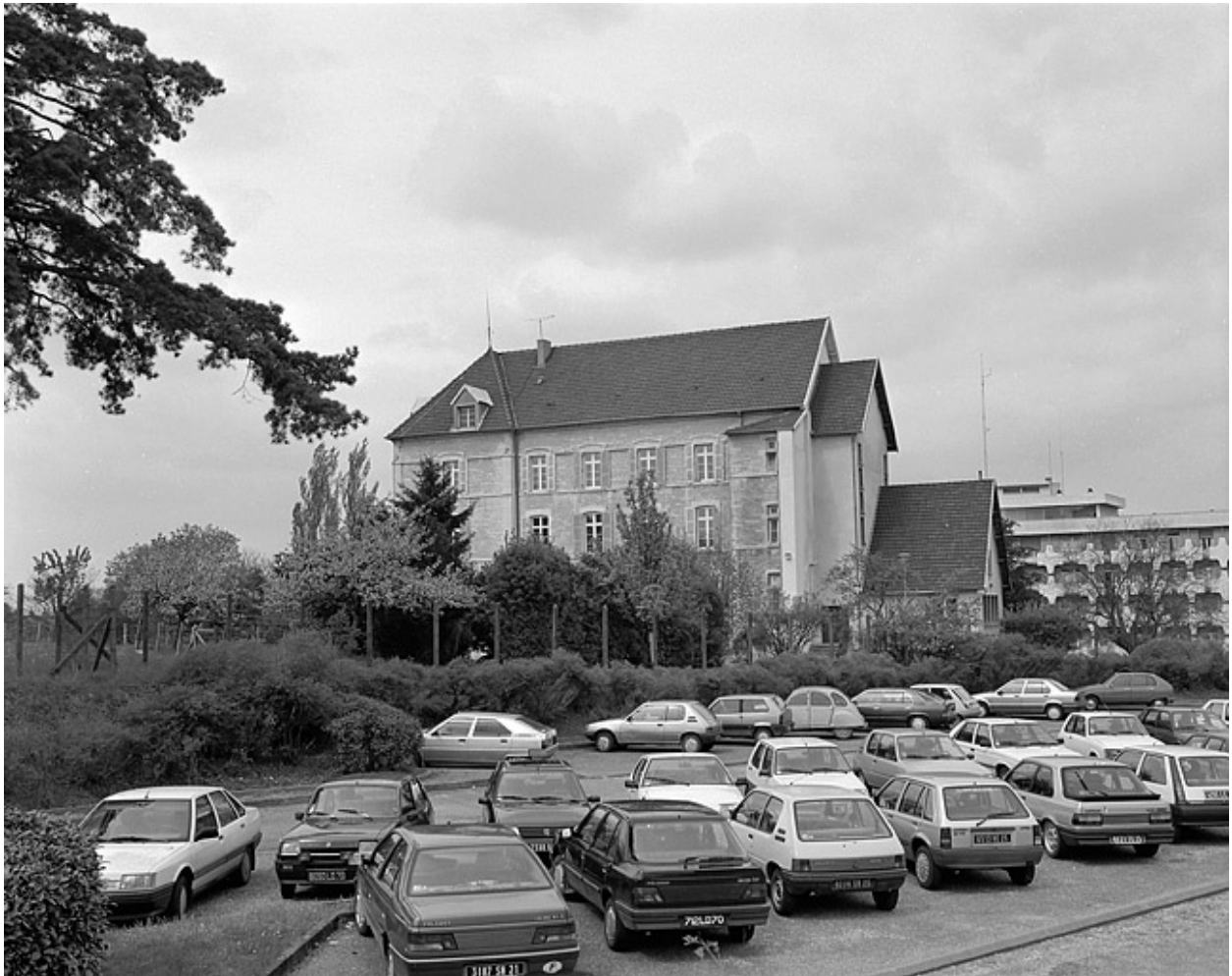
Vue d'ensemble rapprochée.
