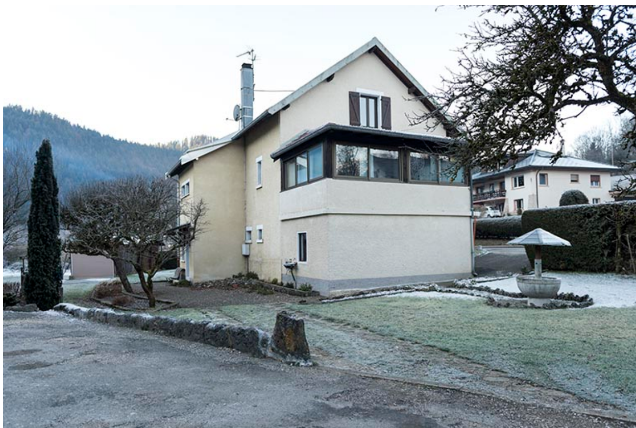
Façades postérieure et latérale gauche.
