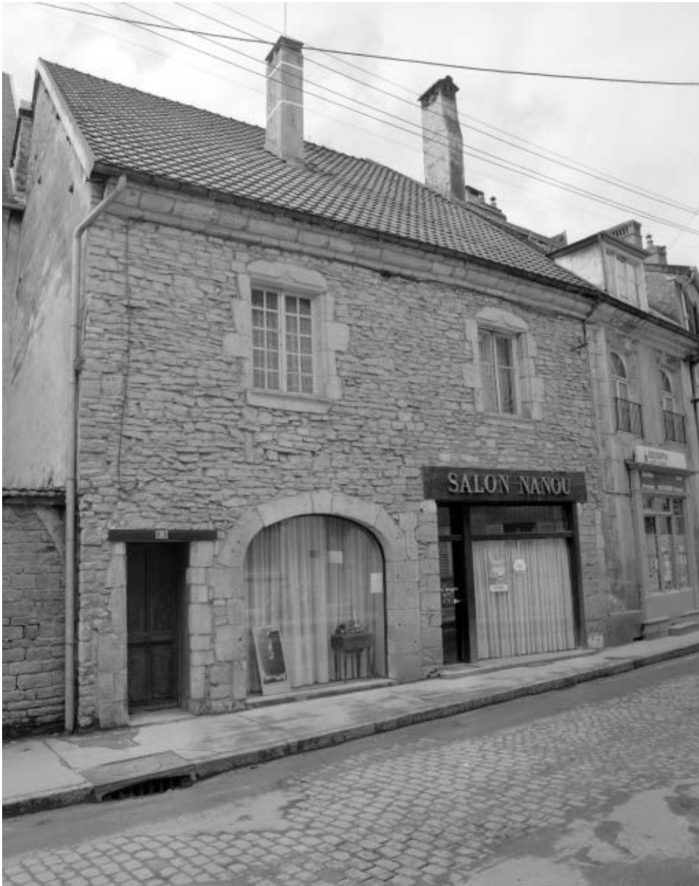
Maison située 9 rue Saint-Laurent.
