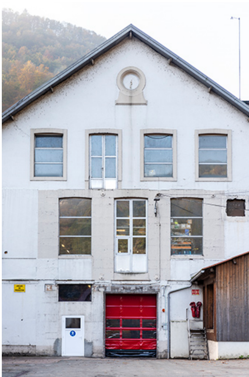
Atelier de fabrication (ancienne pointerie) : façade antérieure.
