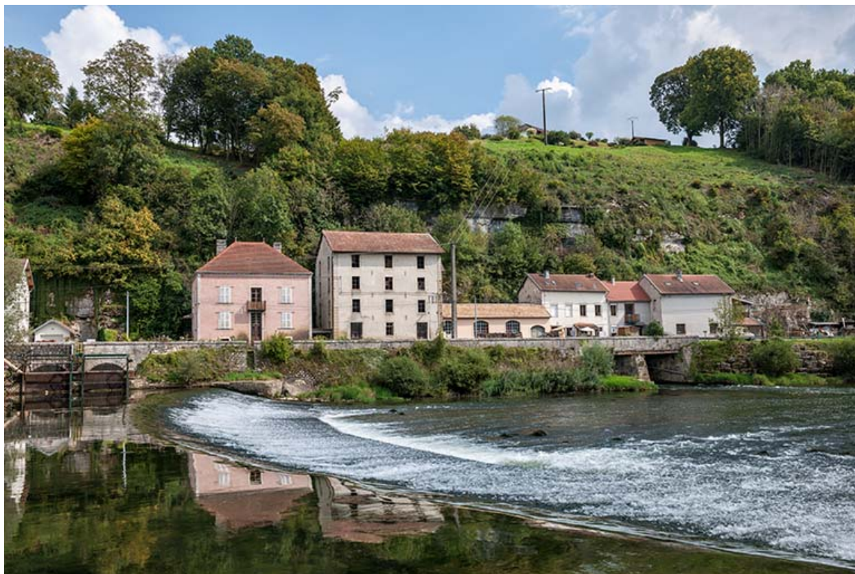
Minoterie de Chaux-lès-Clerval.
