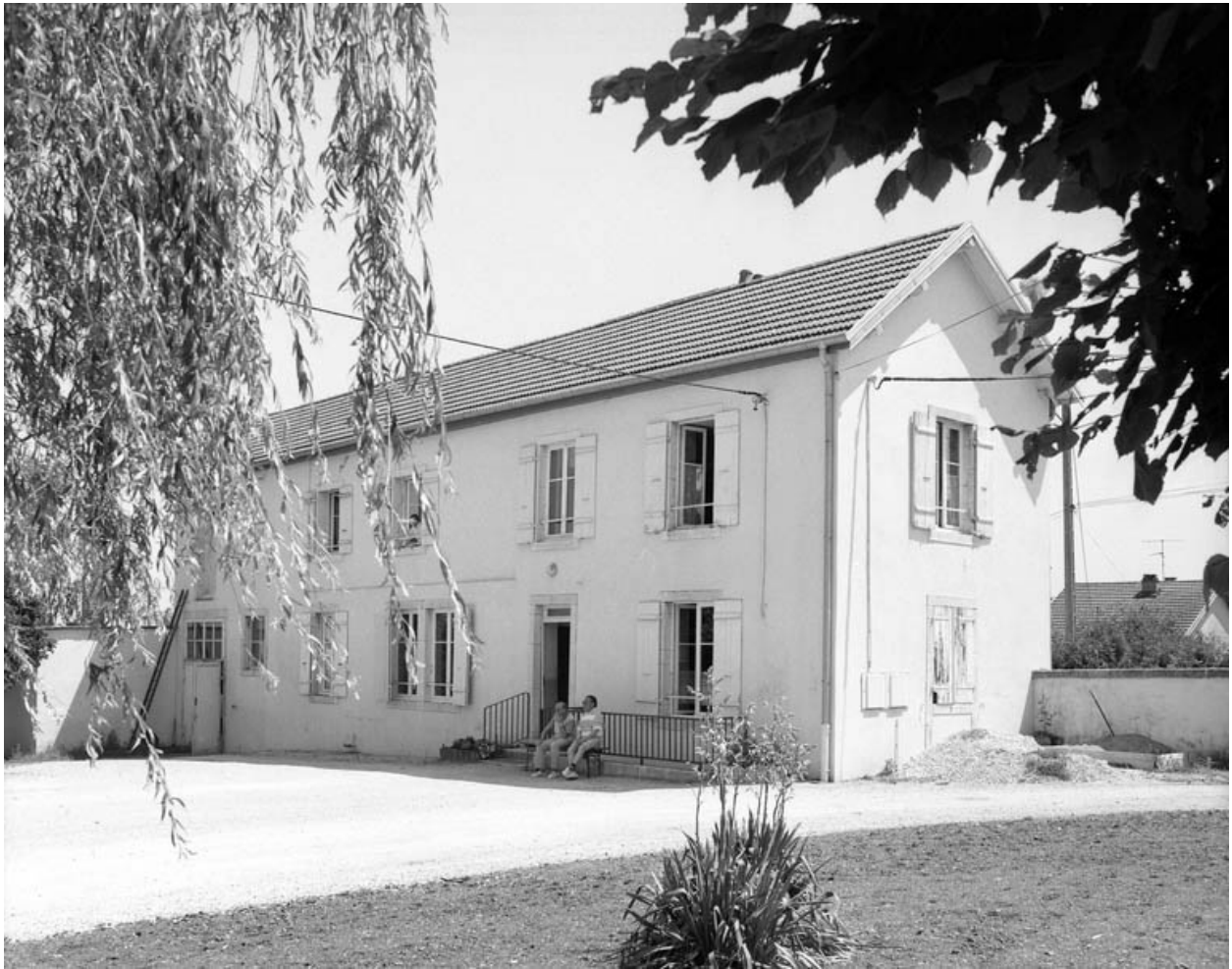
Logement du gardien : de trois quarts droit.
