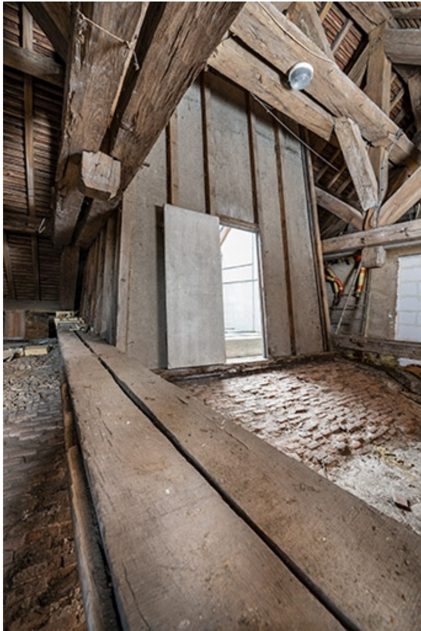
Voûte de l'ancien Bain des Capucins et charpente, porte d'accès à la verrière.
