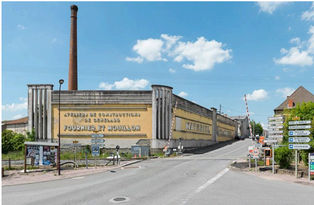
Vue d'ensemble des b timents de l'usine.
