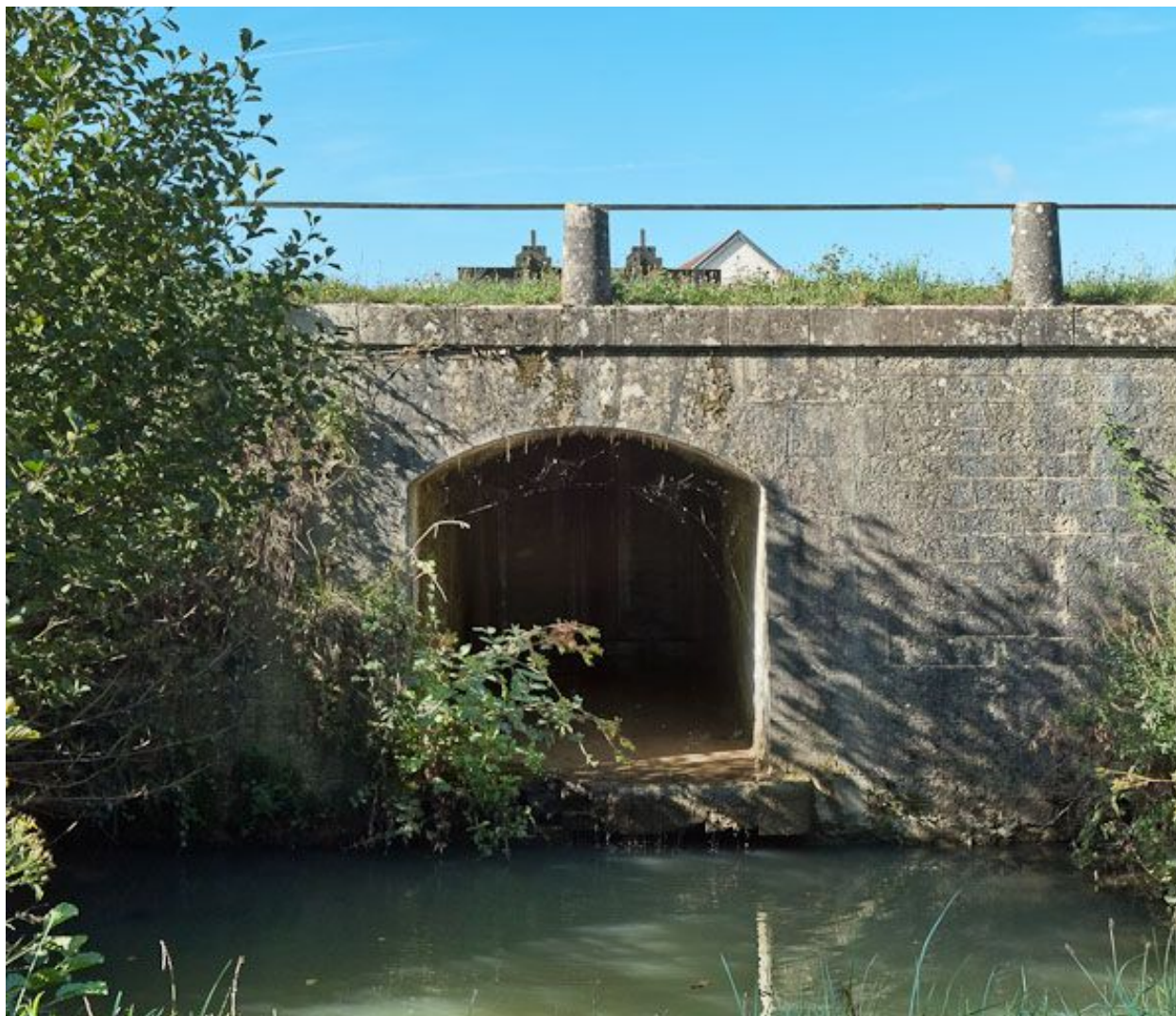
Vue de l'aqueduc.
