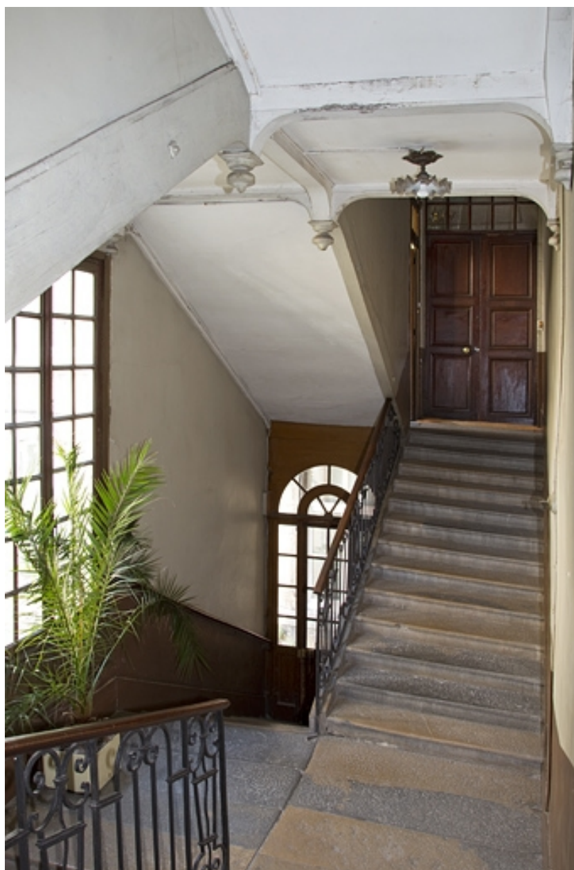
Vue d'ensemble de l'intérieur de l'escalier.
