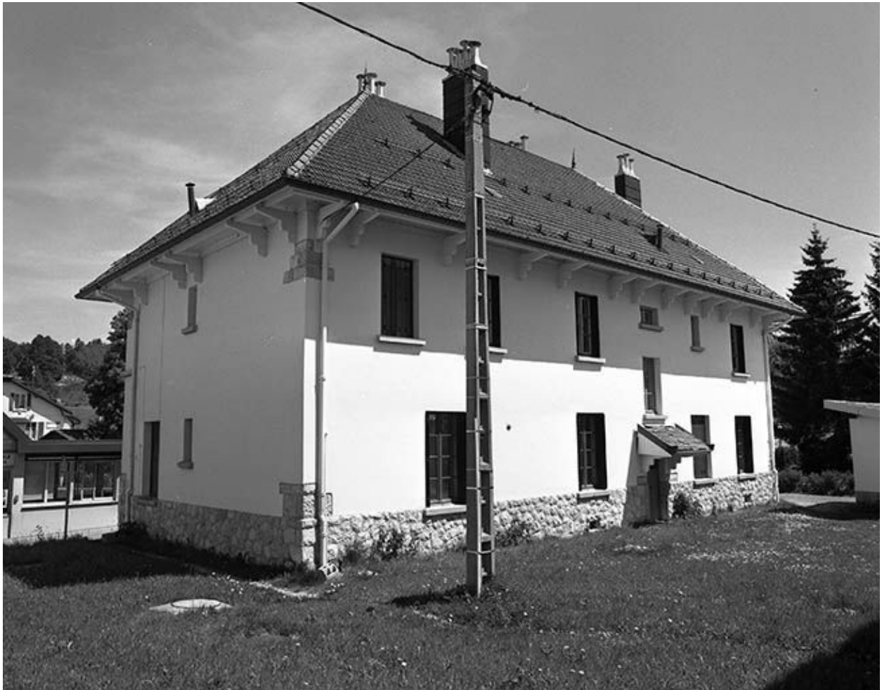
Façade postérieure et face droite.
