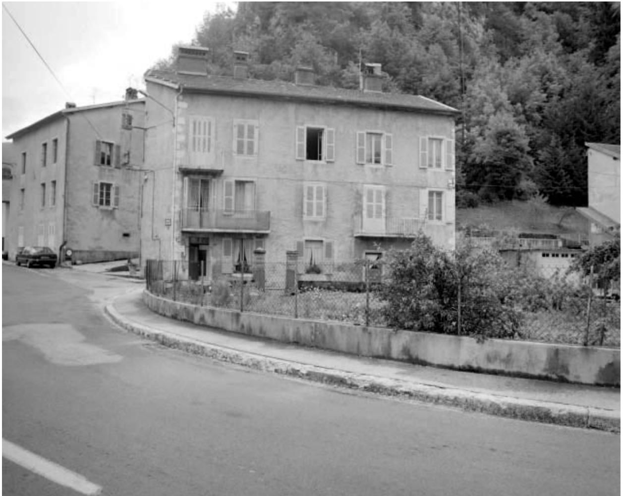
Logement patronal, chemin de la Combe du Marais.
