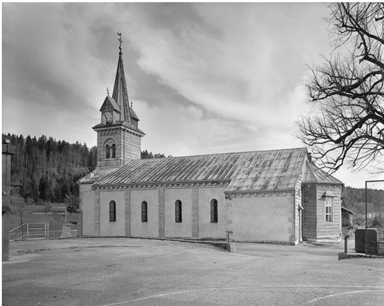
Façade latérale droite.
